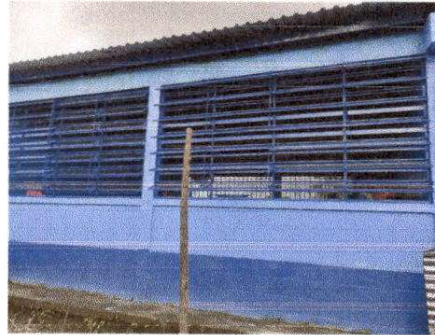
FOTO 2: SUSTITUCION DE VIDRIOS Y PINTURA DE VENTANAS.
