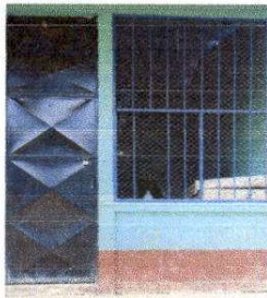
FOTO 5: SUSTITUCION DE VENTANA DE MAYA POR METAL.
